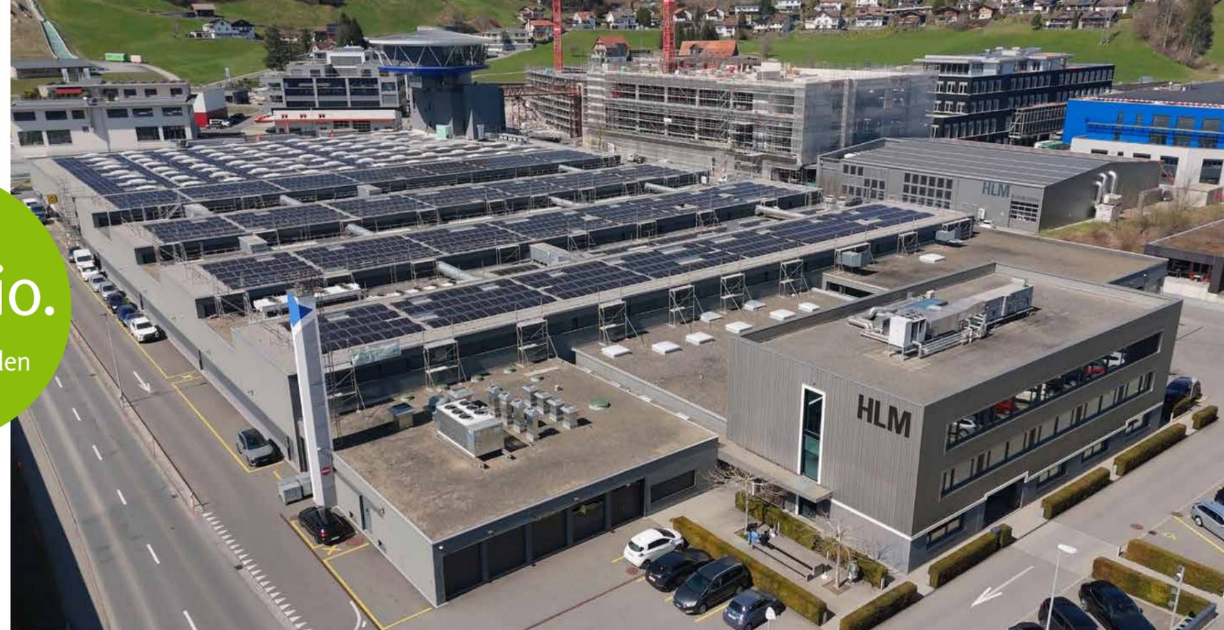
Photovoltaikanlagen auf dem Dach und an der Fassade, die zusammen jährlich rund 1,5 Millionen Kilowattstunden Strom produzieren.
